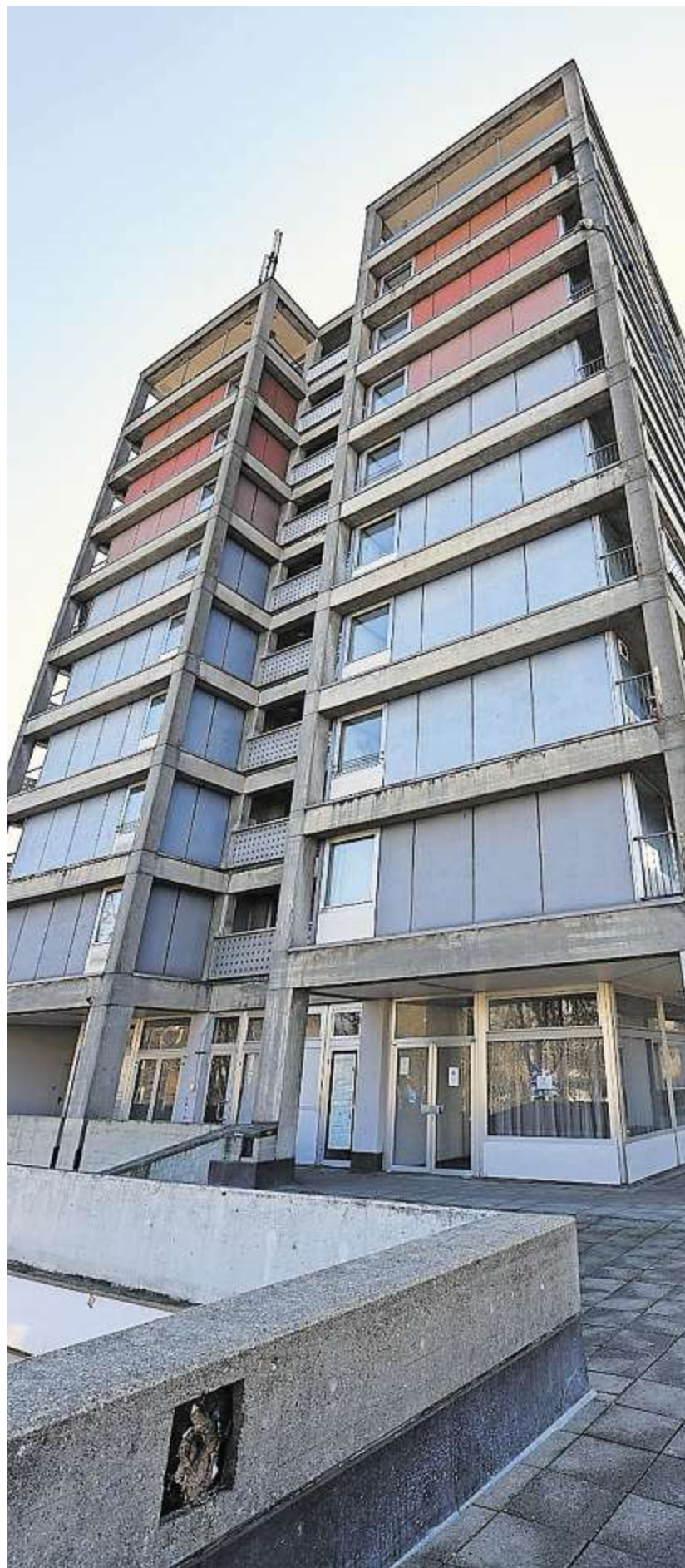
Der Wirsing-Turm soll fallen.
